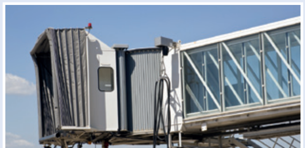
特殊空调应用 (登机廊桥)
